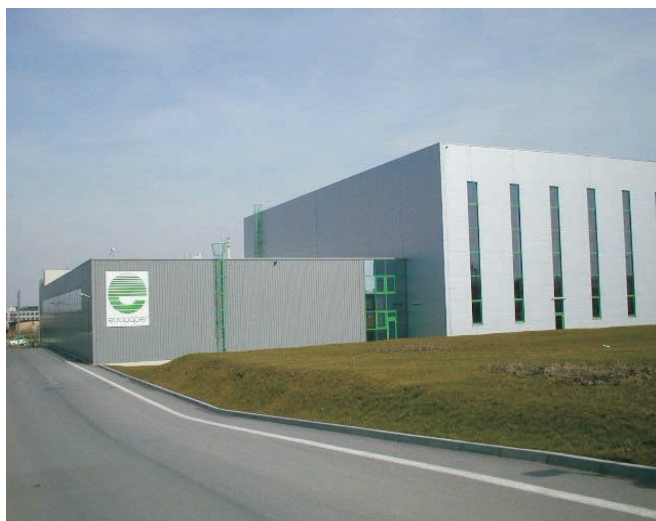
EUROPAPIER Praha 10 realizace 1999 výměra 5500 m 2
